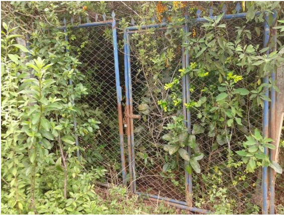
Figura 51: ETE 02 Inoperante e em estado de total abandono
