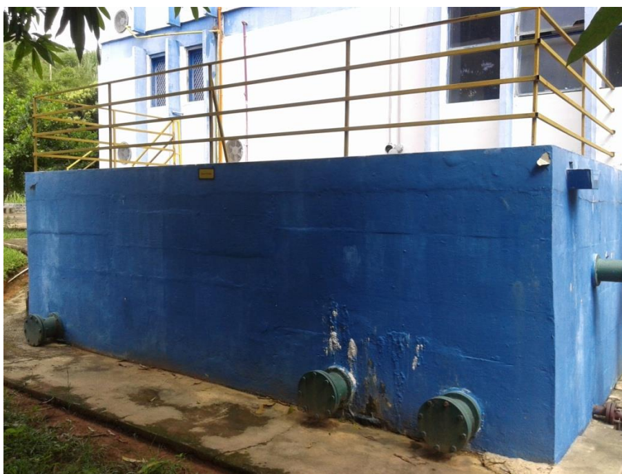
Figura 32 Reservatório da ETA.
