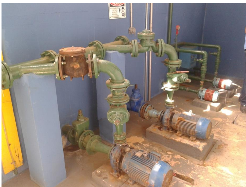
Figura 31 Casa de Máquinas na ETA.
