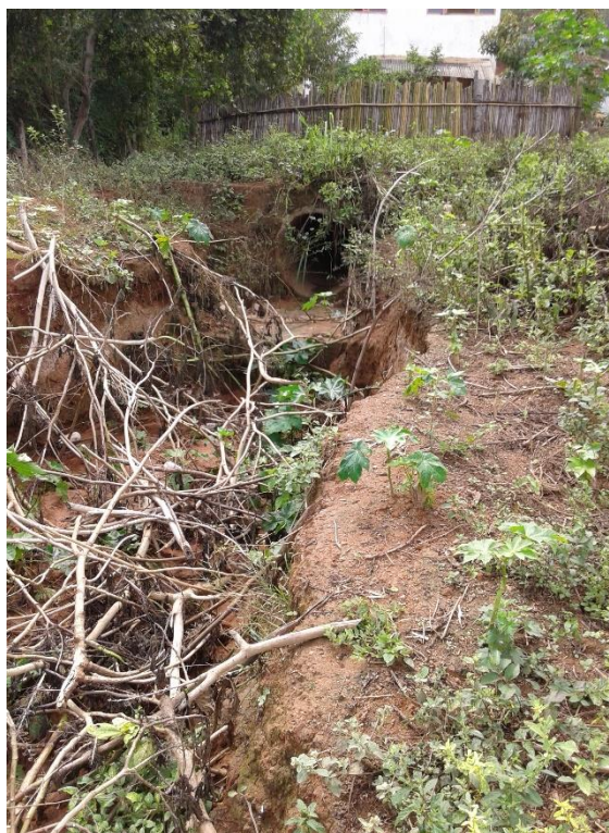
Figura 114 Erosão em ponto de lançamento devido a ausência de estrutura de drenagem.
