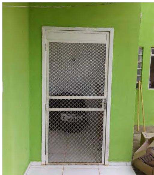
Figura 20. Comodo de armazenagem temporário de Resíduos de Saúde.
