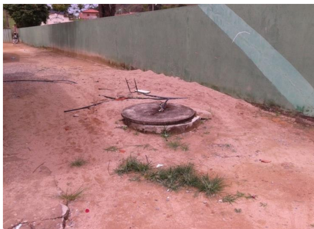
Figura 42 Cisterna dentro do pátio da Escola Municipal de Tabatinga.
