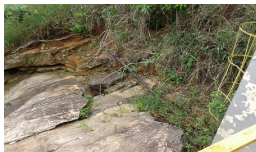
Figura 20 Barragem de captação
