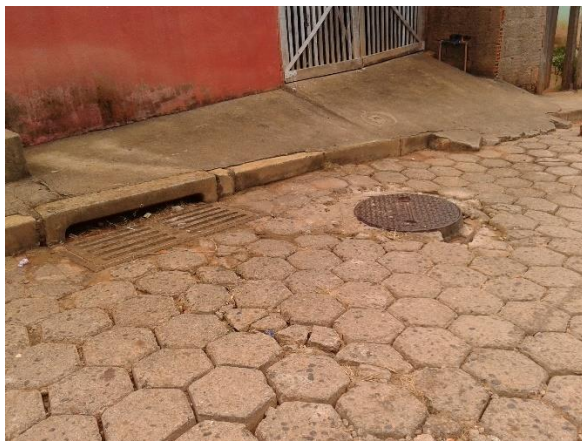
Figura 96. Passeio, meio fio, boca de lobo e pavimento.
