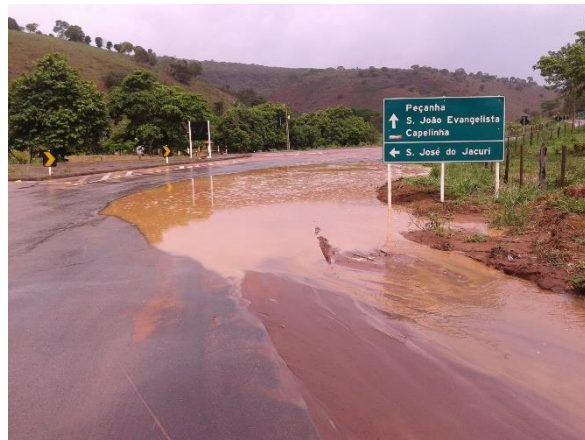
Figura 104. Ponto de alagamento. Rua Dr. Simão da Cunha.
